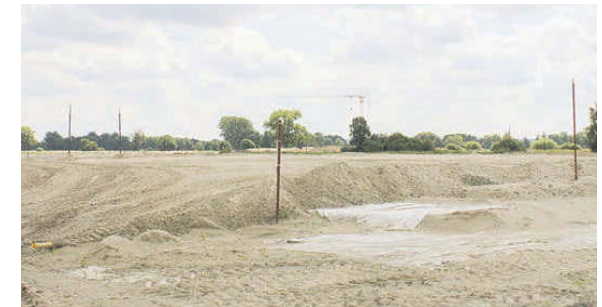
Diese „Sandwüste“ wird die Buxtehuder A26-Ausfahrt
