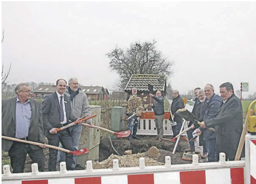
Freude über schnelleres Internet: die Bürgermeister beim ersten Spatenstich Fotos: jd
